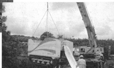
国土交通省排水ポンプ車 松池配備 (5月25日PM)
